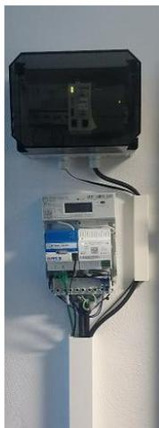
Abbildung 5: Smart Meter Gateway Teststand am Fraunhofer IEE mit dem Gateway (Mitte links) und der Steuerbox (oben im schwarzen Kasten).
