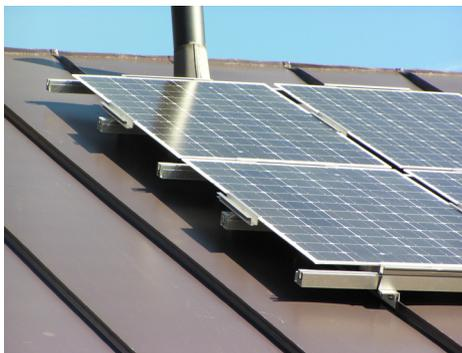
**Abb. 2-3:** Westansicht der Hütte mit den 6 PV-Generatoren je 880 Wp sowie Details der Modultragekonstruktion. Die verwendeten 110-Wp-Module sind rahmenlos.
