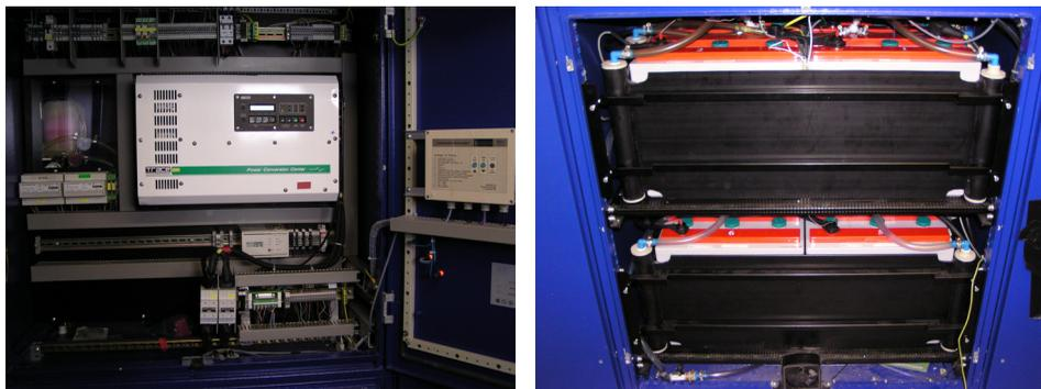
**Abb. 2-6: Ansichten der *BacTERIE*: Im oberen Bereich ist die Elektronik installiert, die Batterien befinden sich darunter in einem gesonderten Batteriefach. Deutlich sind die schwarzen Kühltaschen vor den Zellen zu sehen.**
