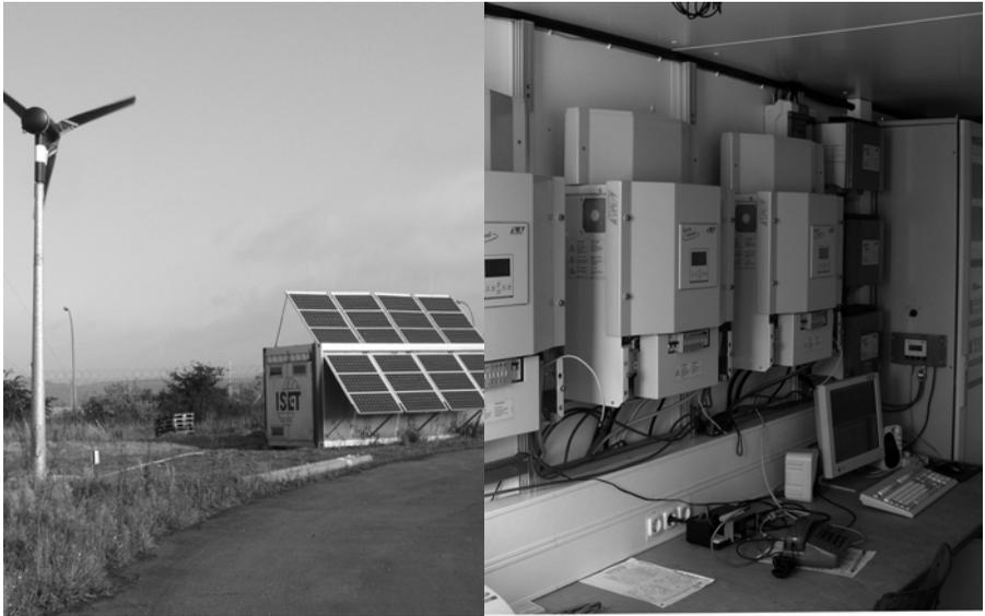
**Abb. 13: ISET Experimentier-Hybridsystem mit PV-Versorgung (links) und 3phasigem Netz (rechts Wechselrichter)**
