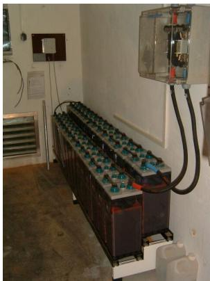
**Abb. 4: Batteriespeicher für 60 V**
