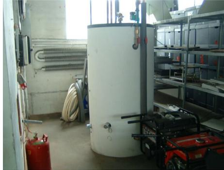
**Abb. 5: Mini-BHKW von ecopower mit 500 l Warmwasserspeicher**
