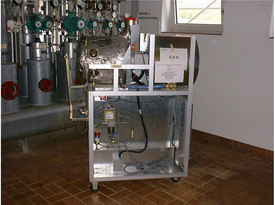
**Abbildung 1** Verwendete Mikrogasturbine C330
