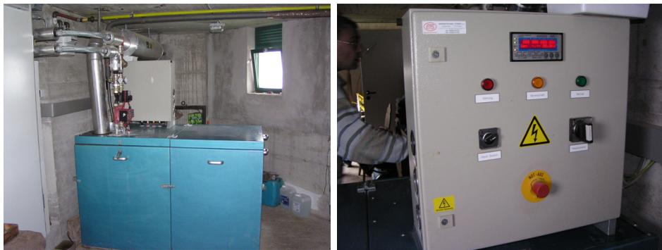
**Abb. 2-7: Einsatz eines mit Flüssiggas betriebenen Blockheizkraftwerkes mit Synchrongenerator**
