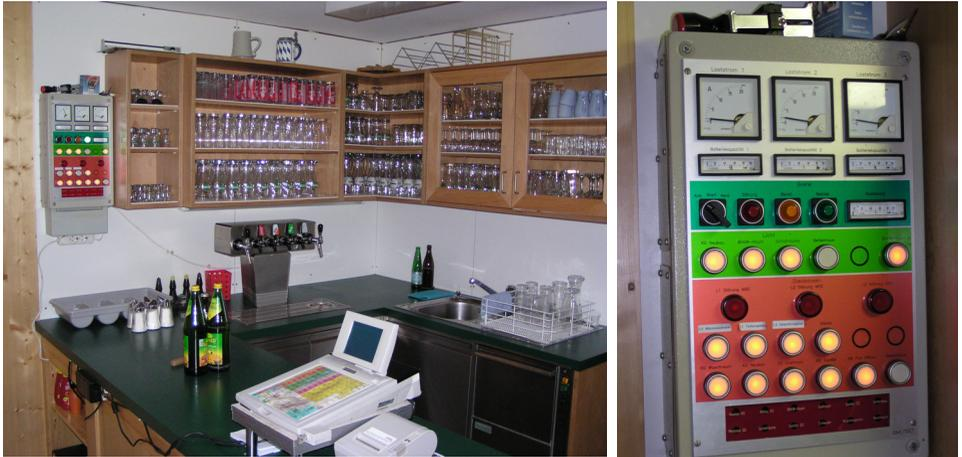
**Abb. 2-8: Informations- und Bedientableau im Schankbereich der Hütte. Wesentliche Informationen wie Lastströme, Ladezustände und Generatorauslastung sind auf einen Blick zu erfassen. Bei Bedarf können einzelne Lastgruppen zentral abgeschaltet oder das BHKW manuell gestartet werden.**
