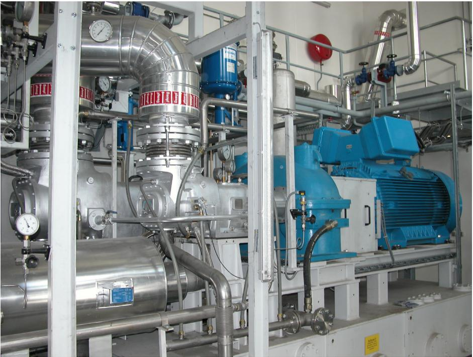
**Abb. 3: Maschinenraum Hartberg: Das Herzstück der neuen Anlage mit zweistufigem Dampf-Schraubenmotor [Niederdruck- (links) und Hochdruck-Stufe (Mitte)], Asynchron-Generator und zugehörigen Leitungen (rechts) /BIOS/, /VITIS 2004/.**
