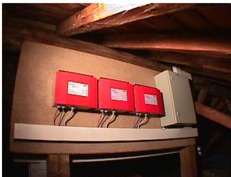
**Abb. 2-4:** Für den Winterbetrieb mit Solarlader können die Solargeneratoren auf halbe Nennspannung umgeschaltet werden (links). Im Sommerbetrieb speisen 6 *Sunny Boys* die Solarenergie wechselstromseitig in das Hüttennetz ein.
