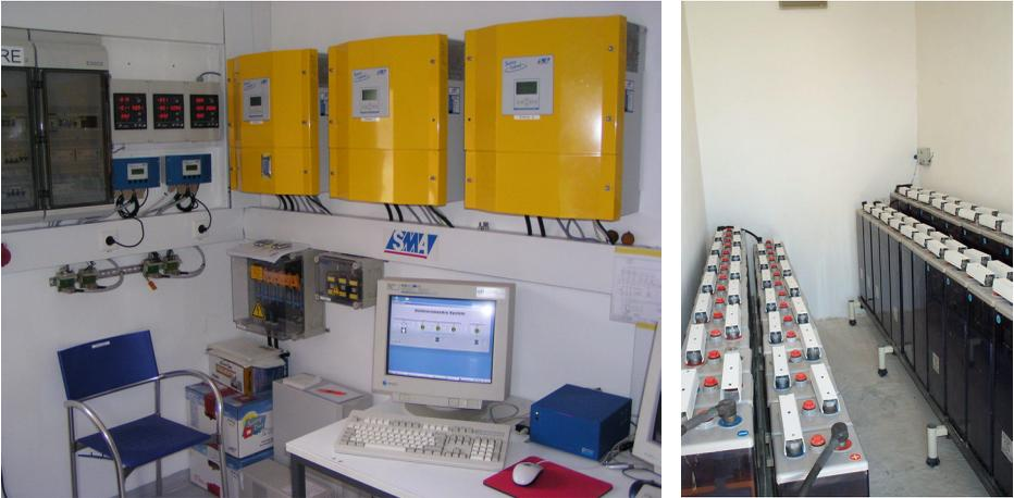
**Abb. 3-4:** Neben der Mess- und Steuertechnik zeigt das linke Bild die drei Batteriestromrichter. Sie bilden ein 10-kVA-Mini-Netz. Die zugehörige Speicherbatterie schließt sich im rechten Bild an. Der zweite, stärkere Batterieverband (rechts) aus dem Projekt PV-MODE verfügt über eine Einrichtung zur Säureumwälzung.
