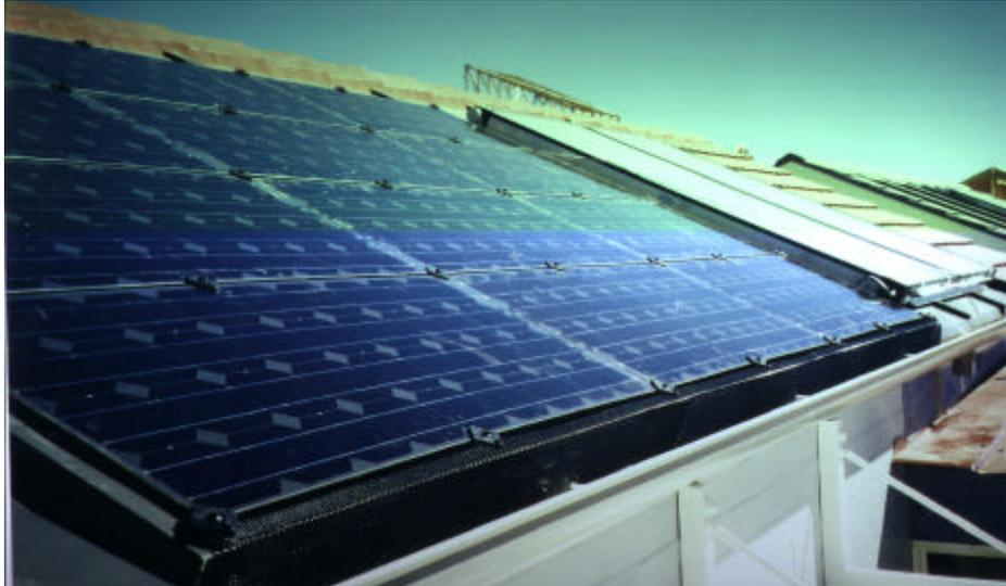
**Abb. 1: Integration der thermischen und elektrischen Nutzung von Solarenergie in die Gebäude des Olympischen Dorfes in Sydney**
