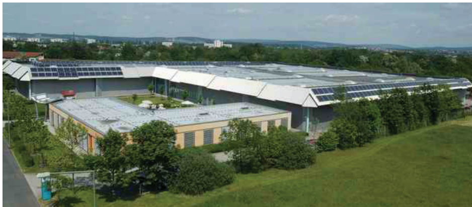
Abbildung 7: 100-kWp-Photovoltaikanlage auf dem Hallendach der Hübner GmbH
