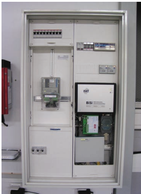
Abbildung 2: Realisierung des BEMI im Testbetrieb
