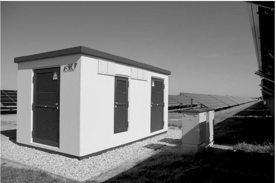
Abbildung 6: Wechselrichterstation SC 1000 MV mit DC-Hauptverteilern [2]
