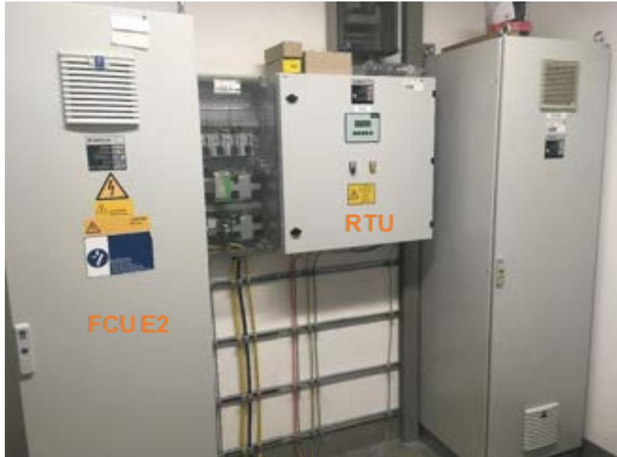
*Abbildung 24: SCADA Raum des UW Kumbdchen mit der FCUE2*
