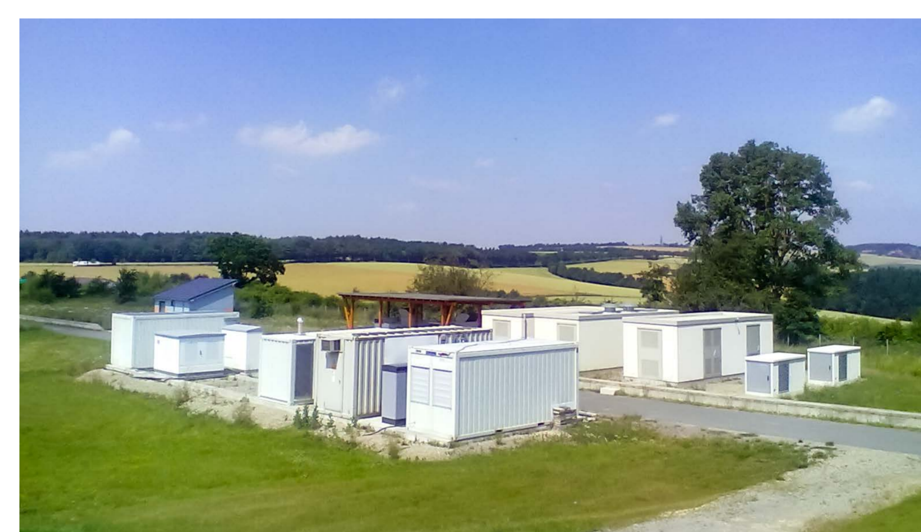
Hybridsystem-Prüfstand im Außenbereich des Testzentrums SysTec
