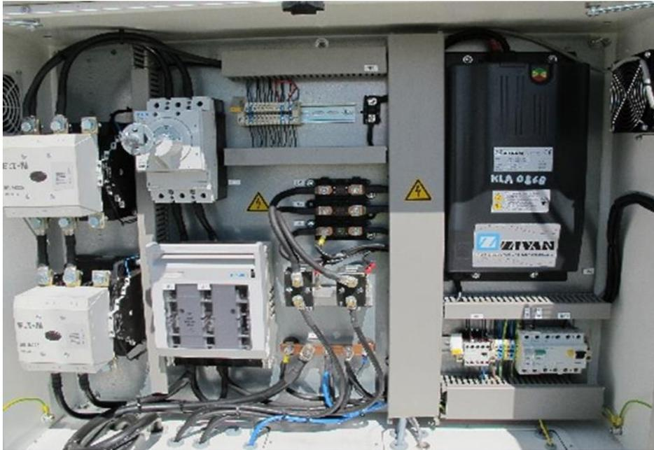
Abb. 108 Schaltschrank der Fluggasttreppe mit Steuerung und Batterieladegerät
