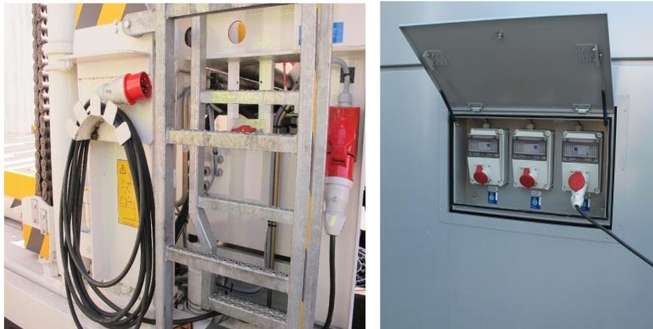
Abb. 93 Anschlussstecker des Ladegerätes (links) und Anschlussboxen am Gebäude (rechts)
