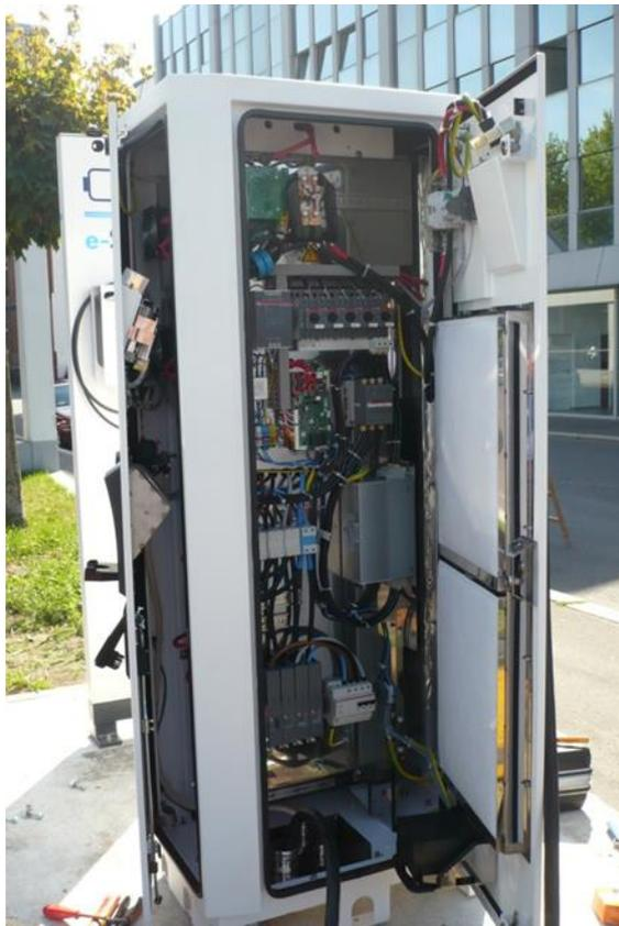
Für die Messung an der Ladestation wurden die AC-Spannungsabgriffe an den Klemmen der AC-Hauptsicherung angebracht und die Stromzangen um die davon abgehenden Versorgungsleitungen gelegt. Die DC-Spannung wurde an den Klemmen des Ladekabels in der Ladestation abgegriffen und der Strom in direkter Nähe erfasst. Die Umgebungs- und Anfangsbedingungen der Messungen stellten sich wie folgt dar:
